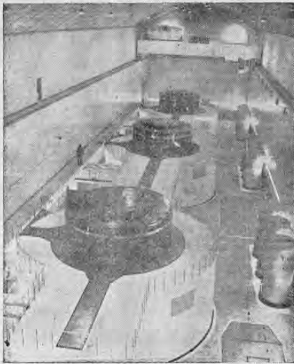
Tres generadores de Tokyo Shibaura Electric Co (TOSHIBA) de Japón de 135.000 kv. cada uno, que miden 10 metros de diámetro, han sido instalados a 45 metros de profundidad en la Planta Eléctrica de Okutadami, que tiene capacidad para suplir energía eléctrica para 2.700.000 familias. Nótese, en la foto, el tamaño gigantesco de los generadores en comparación con el empleado de la izquierda.
